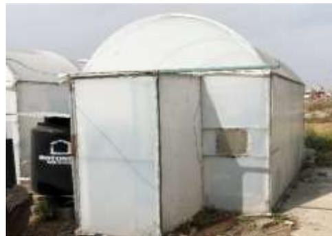
Figura 6.2. Invernadero con un volumen de 23.5 m<sup>3</sup> y área útil de 8.5 m<sup>2</sup>.
