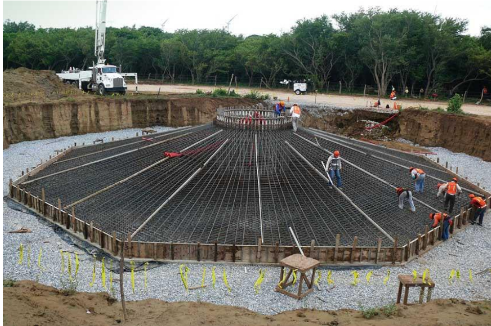
Foto 4. Excavación para colocar aerogeneradores con medidas de 16.7 m x 16.7 m y de 3.2 de profundidad.
