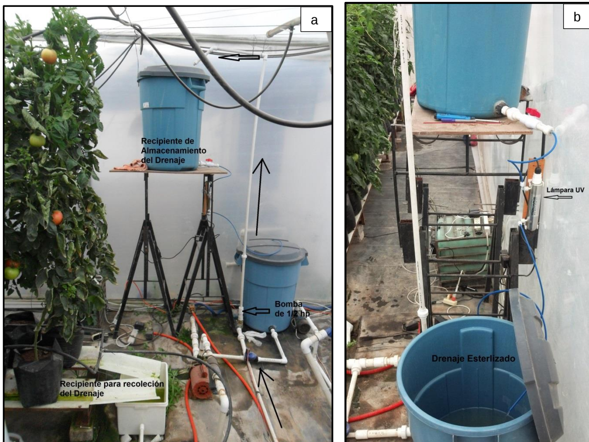
Figura 21. Sistema de recolección de drenaje (a), Sistema de desinfección de drenaje (b)
