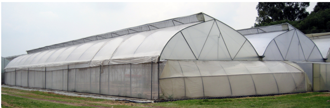
Figura 3.1: Invernadero tipo cenital con ventilación natural donde se realizaron las mediciones.
