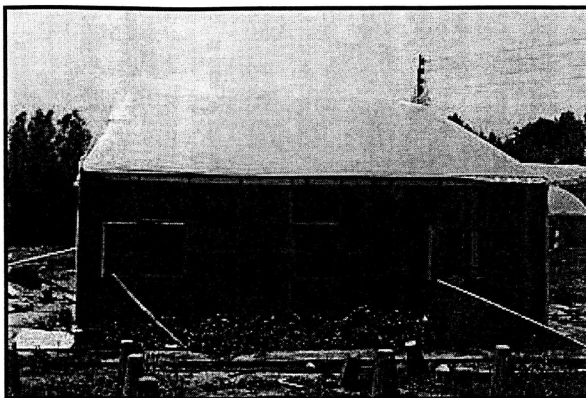
Figura 30. Secador Solar en operación
