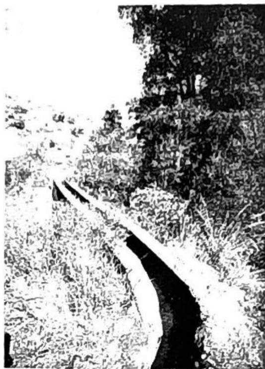
Sistema hidráulico de la parte norte de San Pablo Ixáyoc
