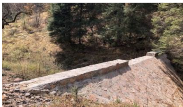
Presa de agua en el ejido de San Juan Totolapan, financiado por CONAGUA
