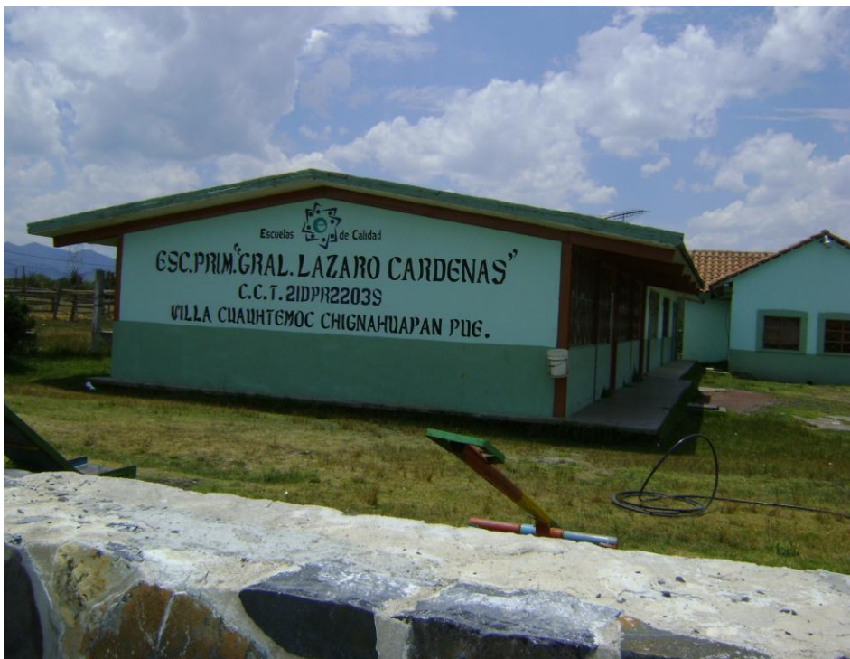
Figura 34: Instalaciones de la Escuela Primaria “Gral. Lázaro Cárdenas”
