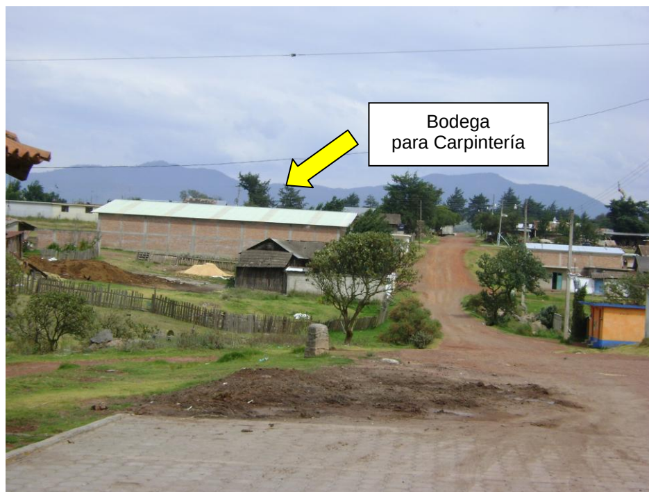
Figura 52: Instalaciones para Carpintería
