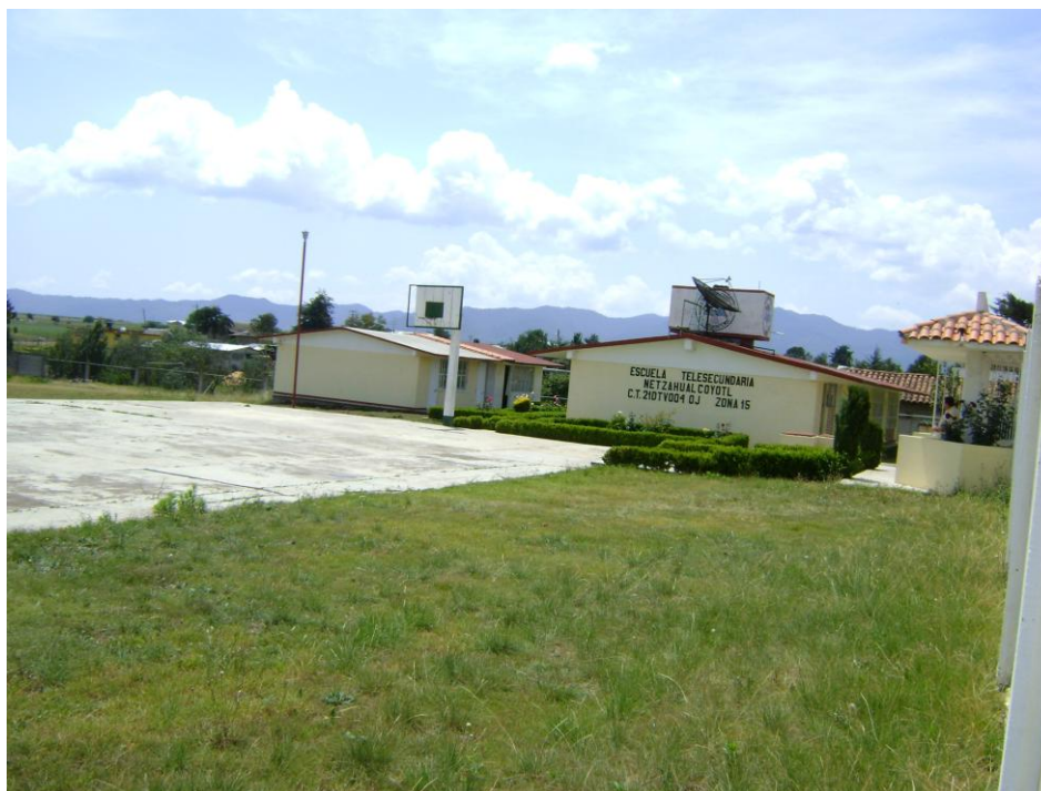
Figura 35: Instalaciones de la Escuela Telesecundaria “Netzahualcóyotl”
