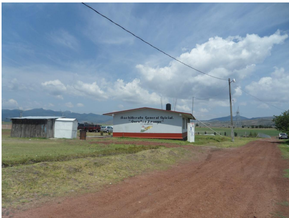
Figura 36: Instalaciones del Bachillerato General Oficial “Doroteo Arango”
