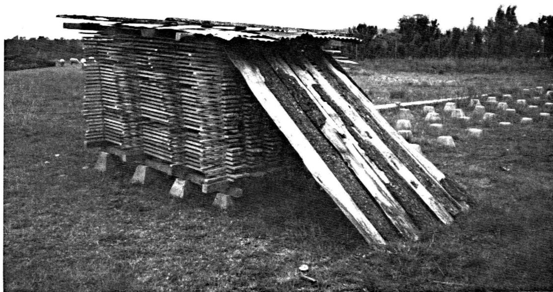
Fig. 7. Pilas para el secado al aire libre.
