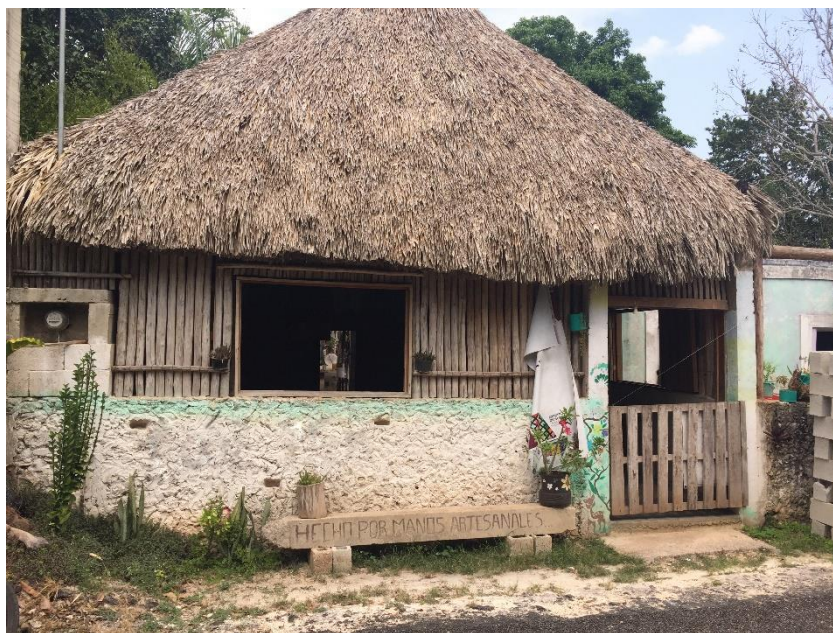
Figura 5. Vista principal del taller Casa de Ixchel en X-pichil (2023). Se aprecia el techo de huano (palma) y la fachada que mezcla mampostería con el uso de maderas locales Fuente: Archivo personal
