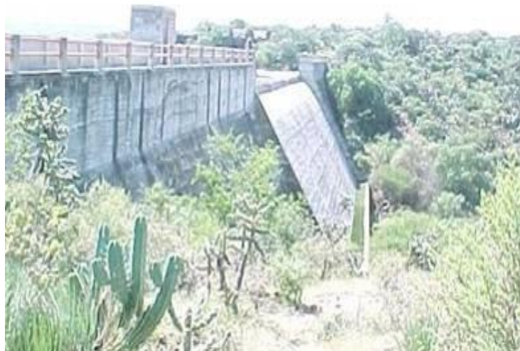
Figura 2-38. Vista de la presa Vicente Aguirre
