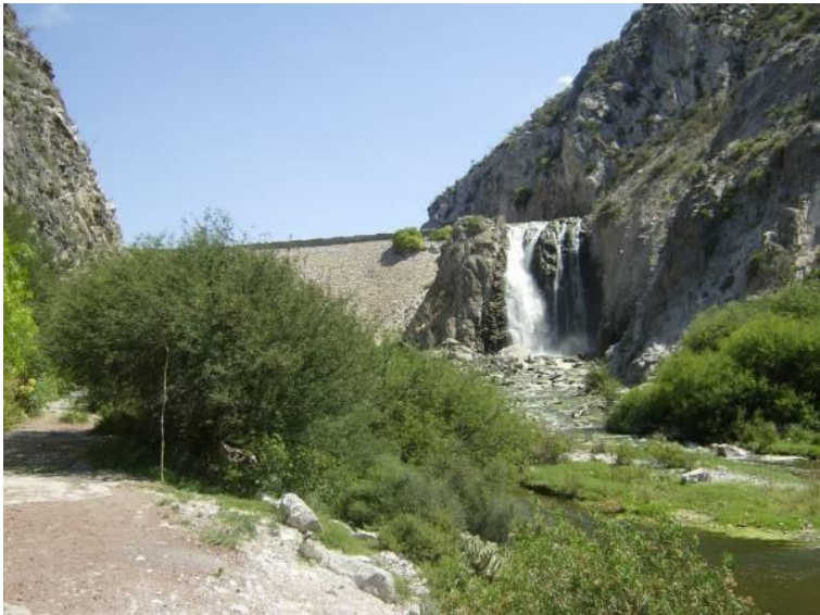
Figura 2-43. Vista de la presa Debodhé
