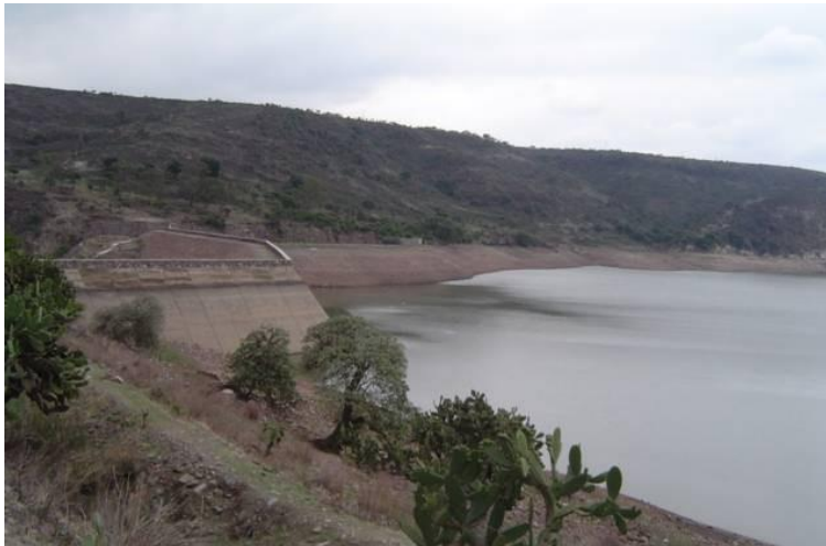
Figura 2-18. Vista de la cortina y parte del vaso de la presa Taximay
