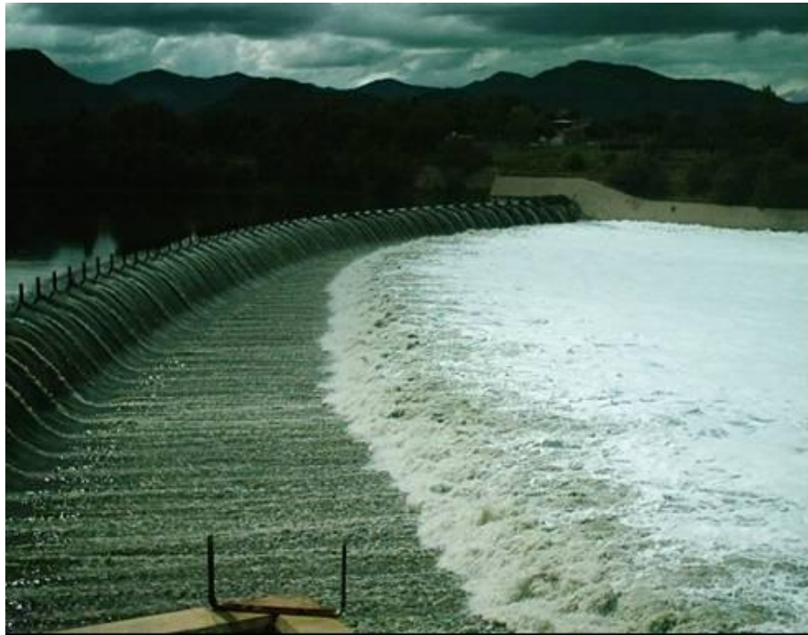
Figura 2-28. Cresta vertedora de la presa Endhó
