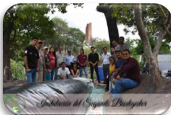
Instalación del segundo biodigestor en la comunidad de San Juan Raboso
