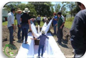
Instalación del primer biodigestor en la comunidad de San Juan Raboso
