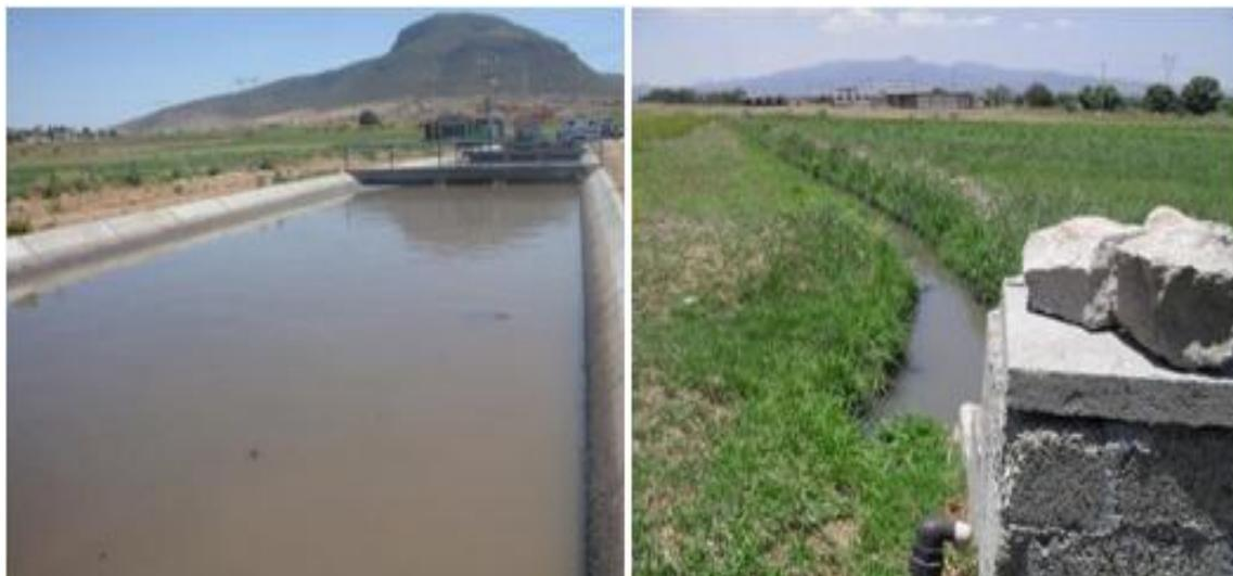
Figura 9. Cárcamo y riego rodado con bombeo en el DR 028 Tulancingo, Hidalgo.
