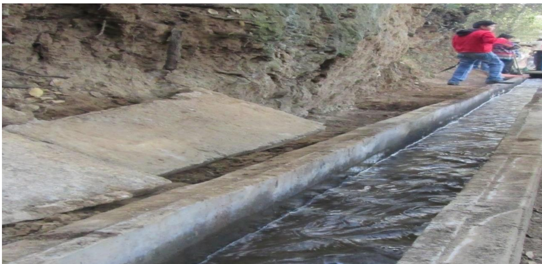
Figura 36. Canal principal de distribución del agua para riego. Estos sistemas de canales fueron contruidos por la propia comunidad hace aproximadamente 30 años, y se les da mantenimiento dos veces por año.
