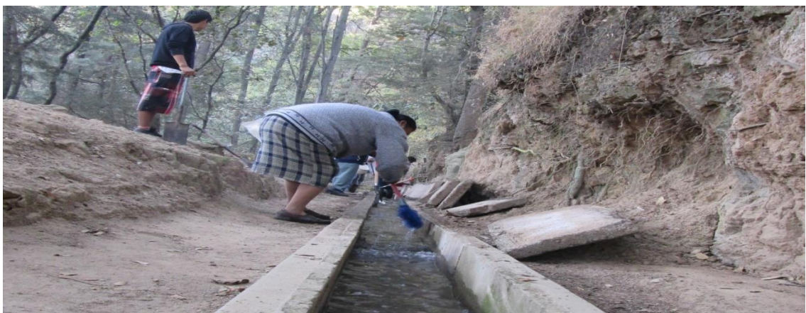
Figura 34. Limpieza y mantenimiento de los canales de conducción y distribución del agua para riego
