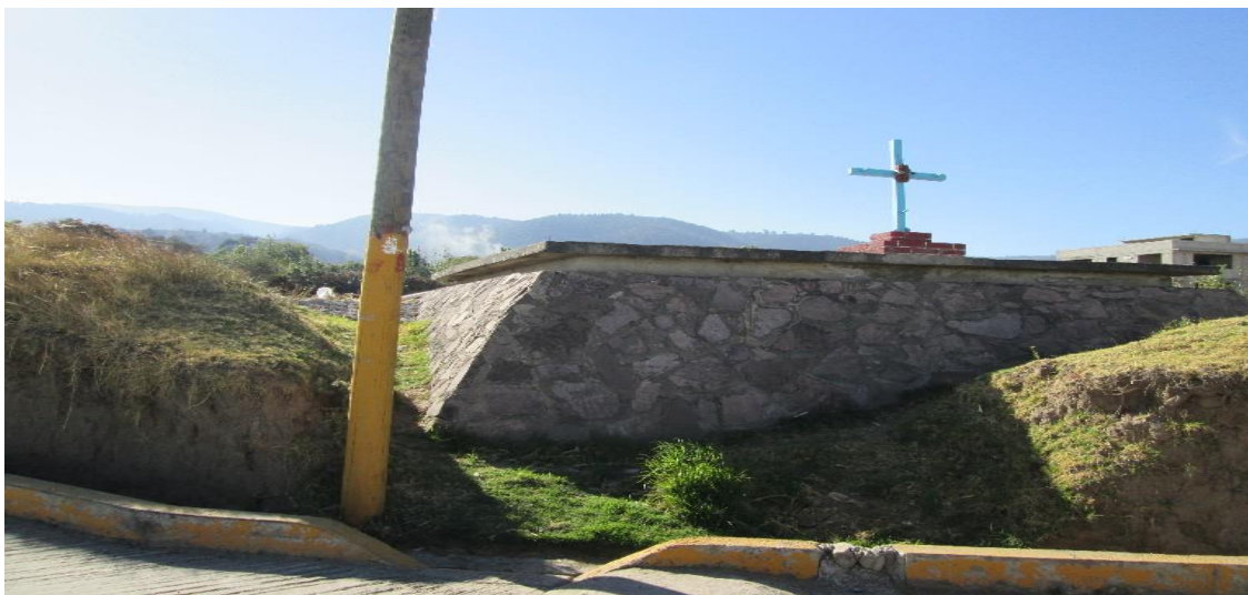
Figura 23. Depósito de agua entubada Huepalcalco. Este depósito tiene una dimensión aproximada de 7 x 7 metros de base por 3 de altura y actualmente está inactivo.
