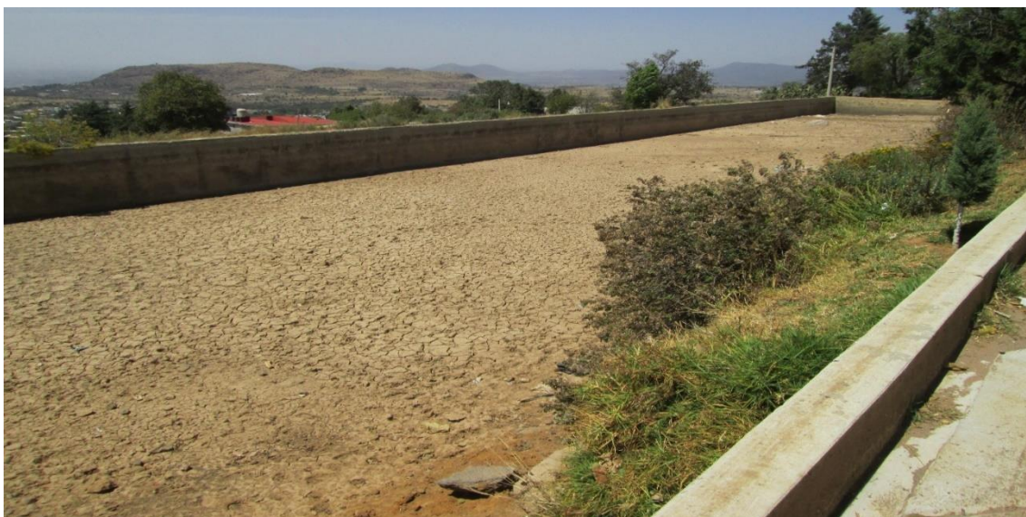
Figura 37. Jagüey Cuahutenco. La presente fotografía da cuenta del problema de escasez del agua que enfrenta este sistema de riego.
