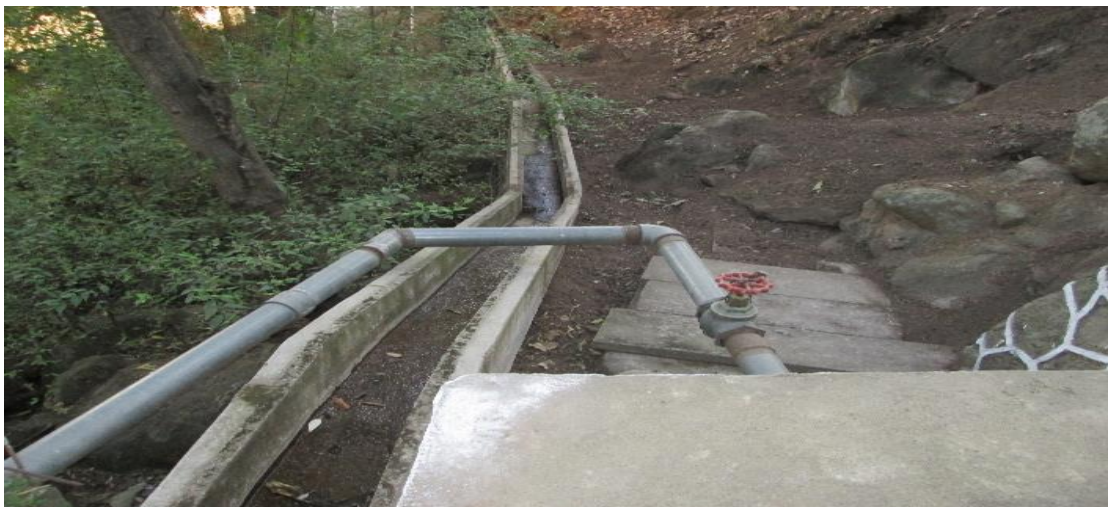
Figura 22. Depósito de agua entubada Tlacopilco. Este depósito tiene una dimensión aproximada de 7 x 7 metros de base por 3 de altura.
