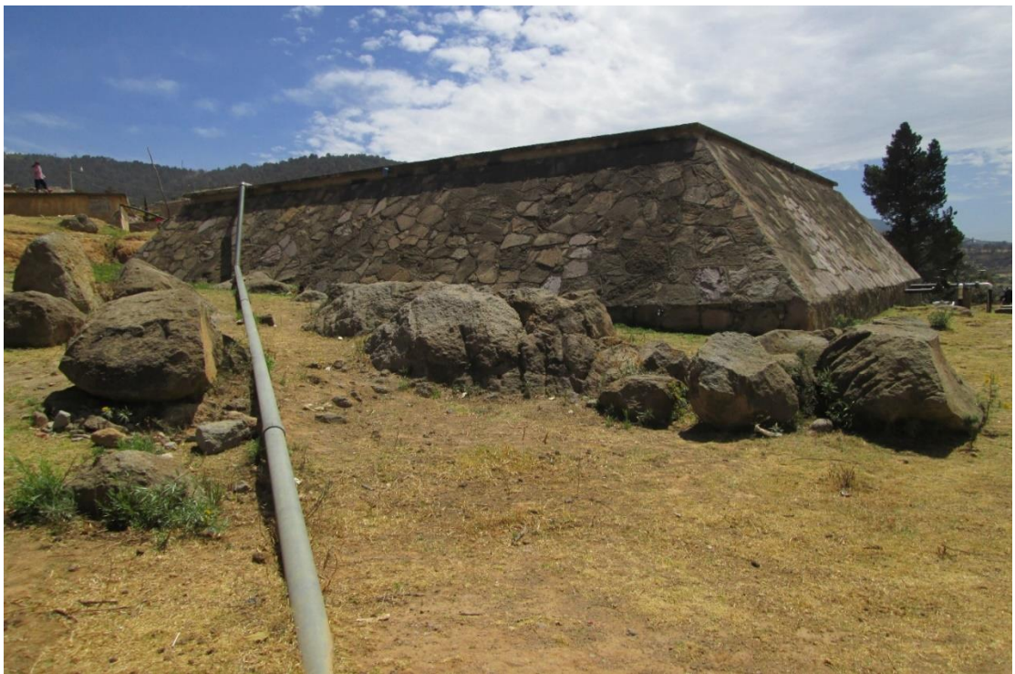
Figura 28. Depósito de agua potable Cuahutenco. En esta imagen se observa la tubería que conduce el agua por bombeo al depósito Cuahutenco, ubicado en la parte alta, con relación al manantial Atexcac. Este depósito tiene una dimensión aproximada de 10 x 10 metros de base por 3 de altura.
