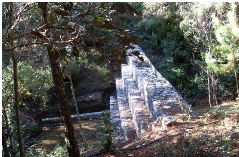
Figura 17. Obras de conservación de suelos y agua: presa de gavión, en la zona centro.
