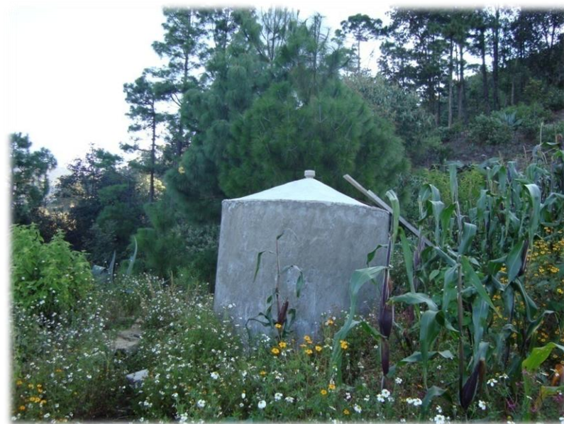
Figura 15. Tanque de ferrocemento, en la zona de transición.
