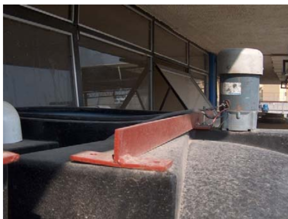
Figura 3.17 Apariencia final del soporte sobre el tinaco y el sistema de agitación.
