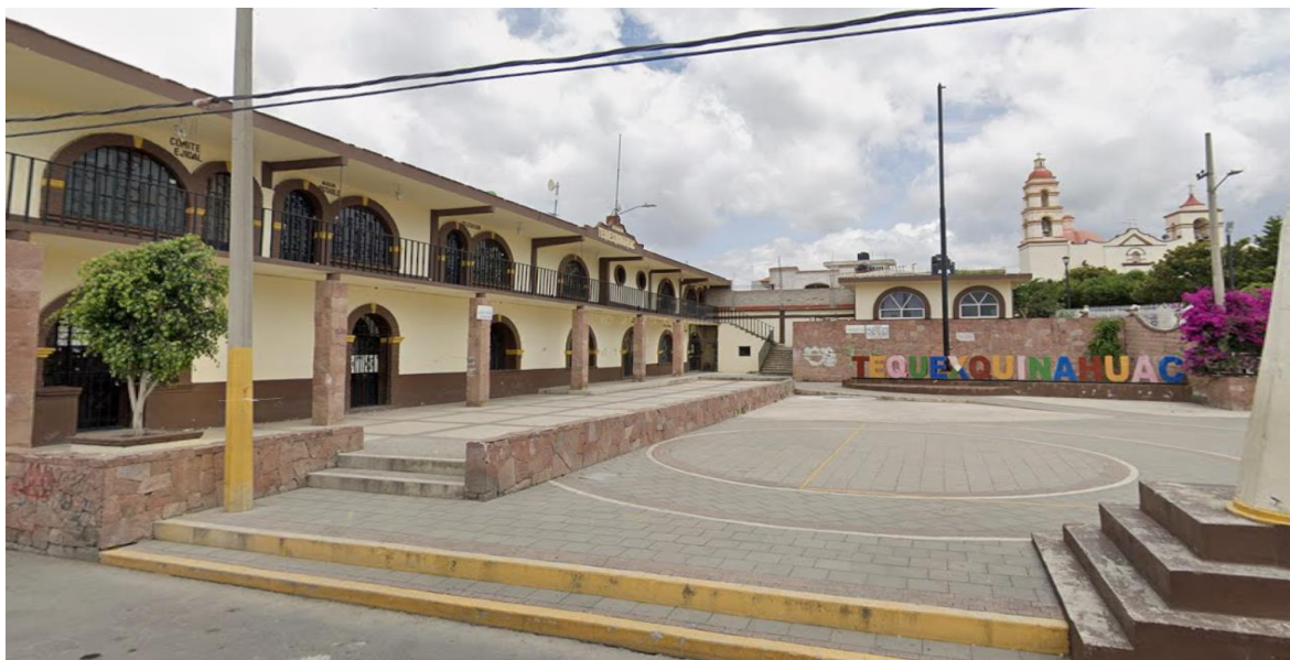
Figura 17. Instalaciones del plantel CBTA 35 ET
