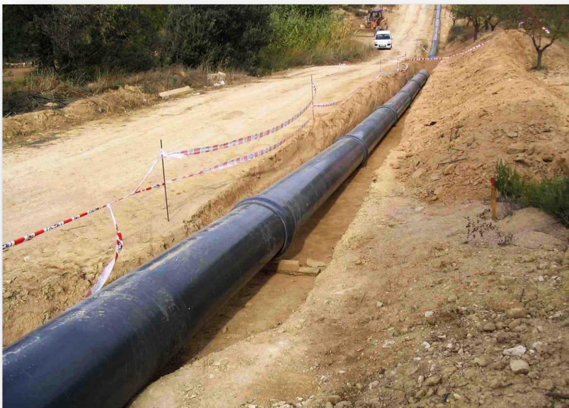
Fotografía. 19. Instalación de tubería
