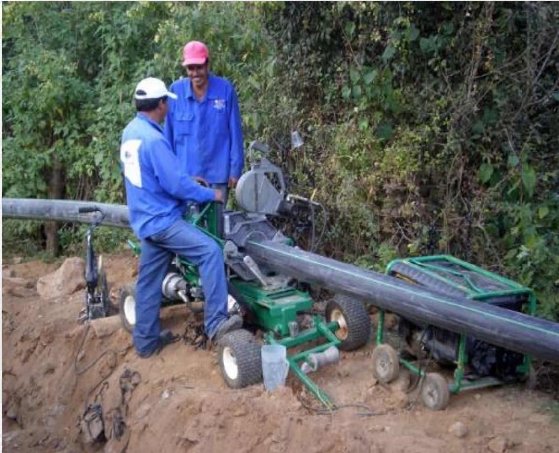
Fotografía. 23: mantenimiento de tubería.
