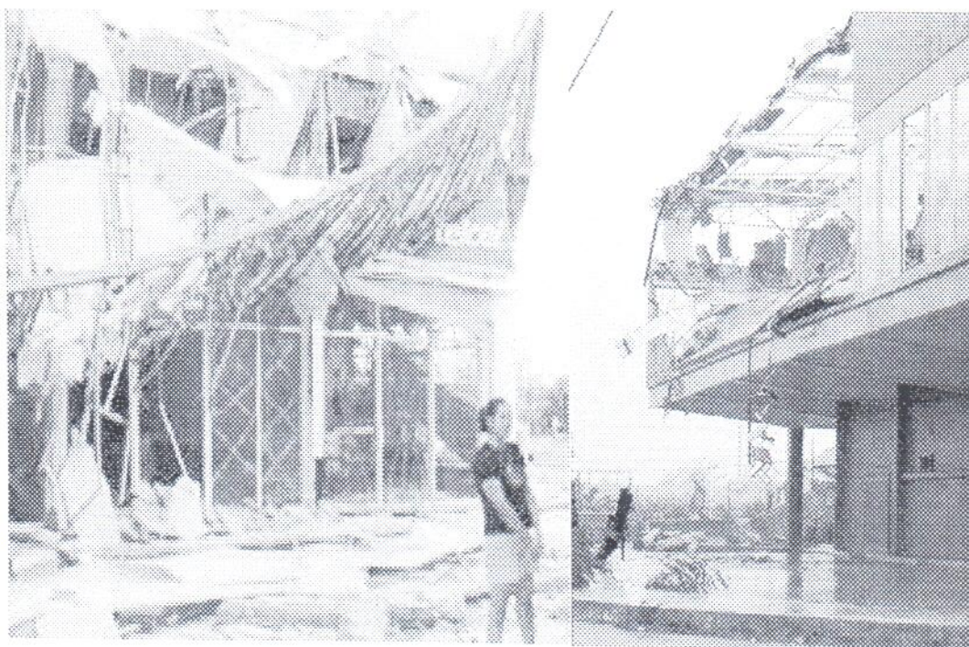
Figura 7. Centros comerciales, viviendas, hoteles y restaurantes dañados.
