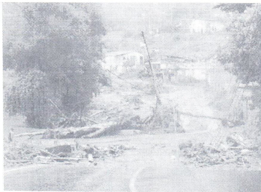
Figura 3. Carretera bloqueada y línea de transmisión eléctrica dañada en el Estado de Chiapas.
