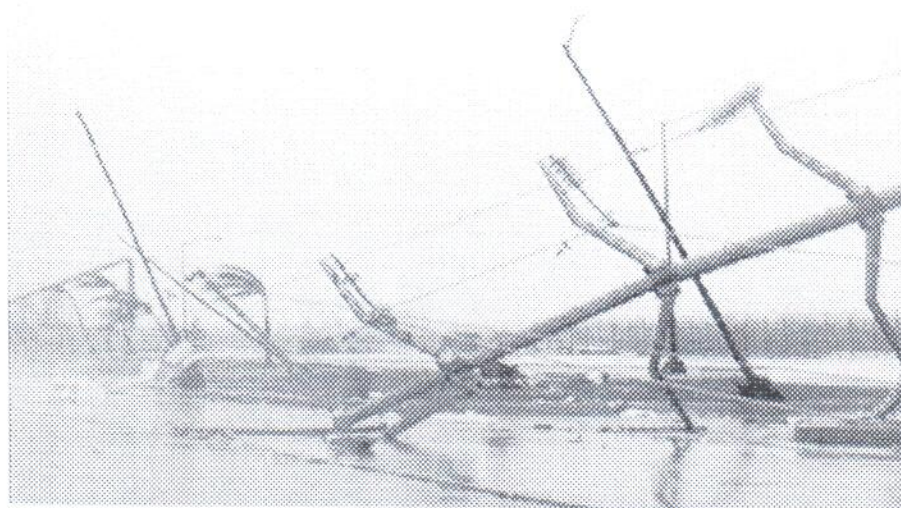
Figura 9. Líneas de transmisión eléctrica dañadas por el huracán.
