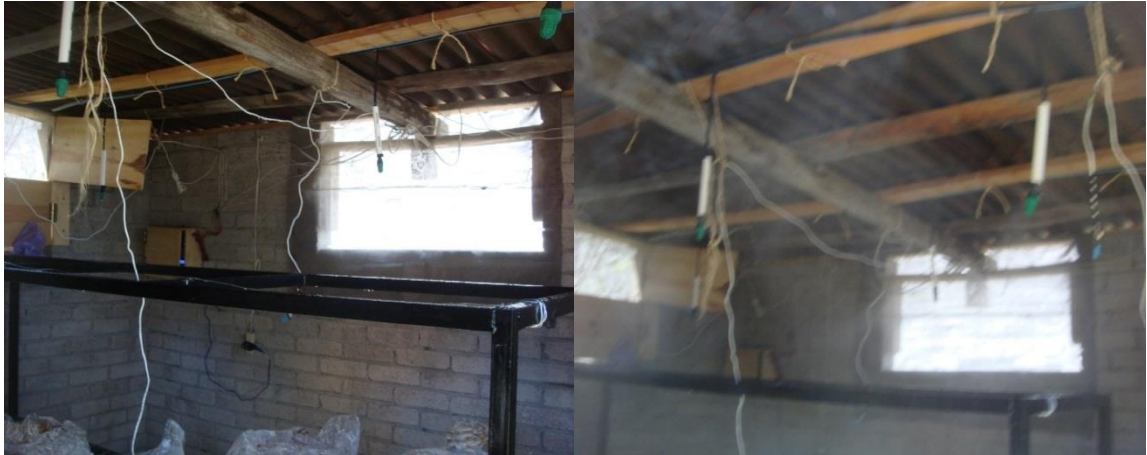
Figura 30. Sistema de nebulización funcionando en la unidad de producción. Fuente: Autor, 2015.
