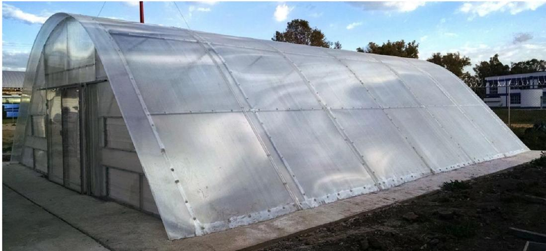
Figura 1. Sistema secador solar tipo invernadero de forma parabólica y cubierta de policarbonato ubicado en Chapingo, México.
