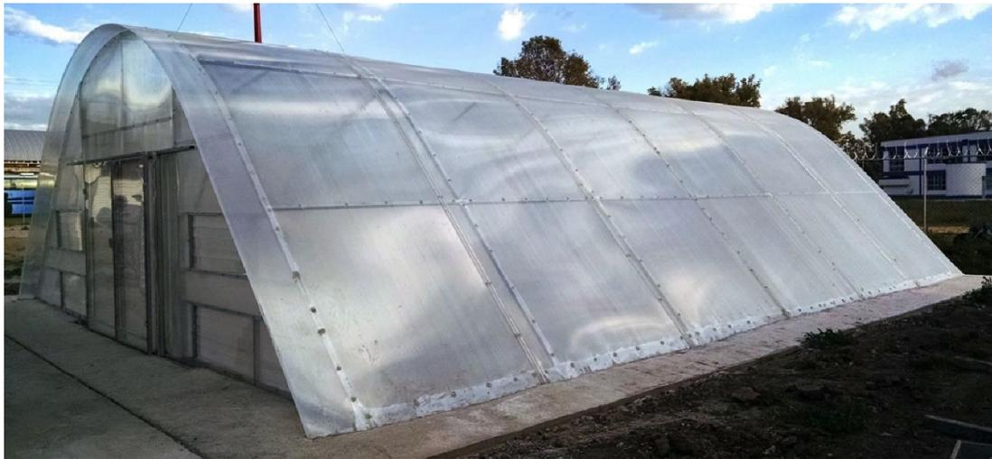
Figura 2. Sistema secador solar tipo invernadero de forma parabólica y cubierta de policarbonato construido en Chapingo, México.
