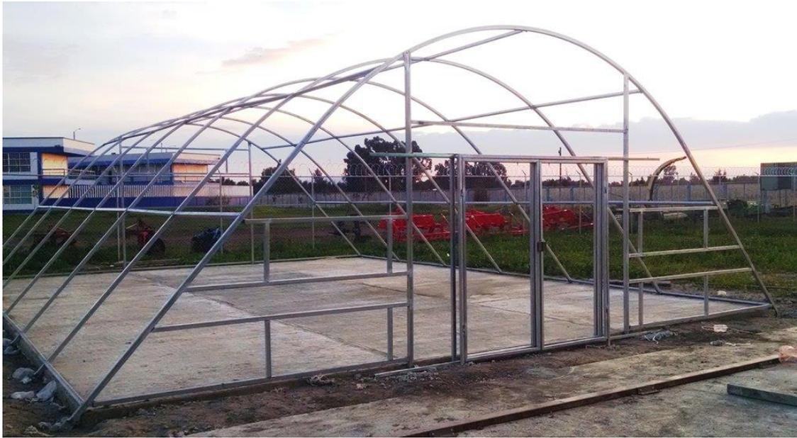
Figura 1. Estructura en acero galvanizado del sistema secador solar tipo invernadero construido en Chapingo, México.
