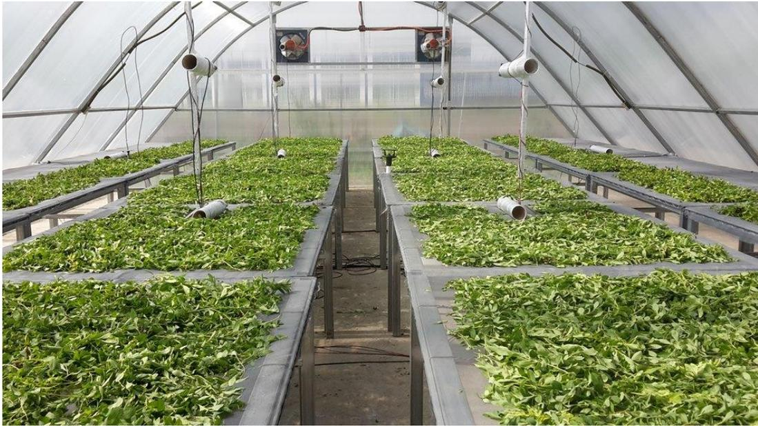
Figura 4. Deshidratado de *Stevia* en el sistema secador solar tipo invernadero construido en la Universidad Autónoma Chapingo, Chapingo, México.
