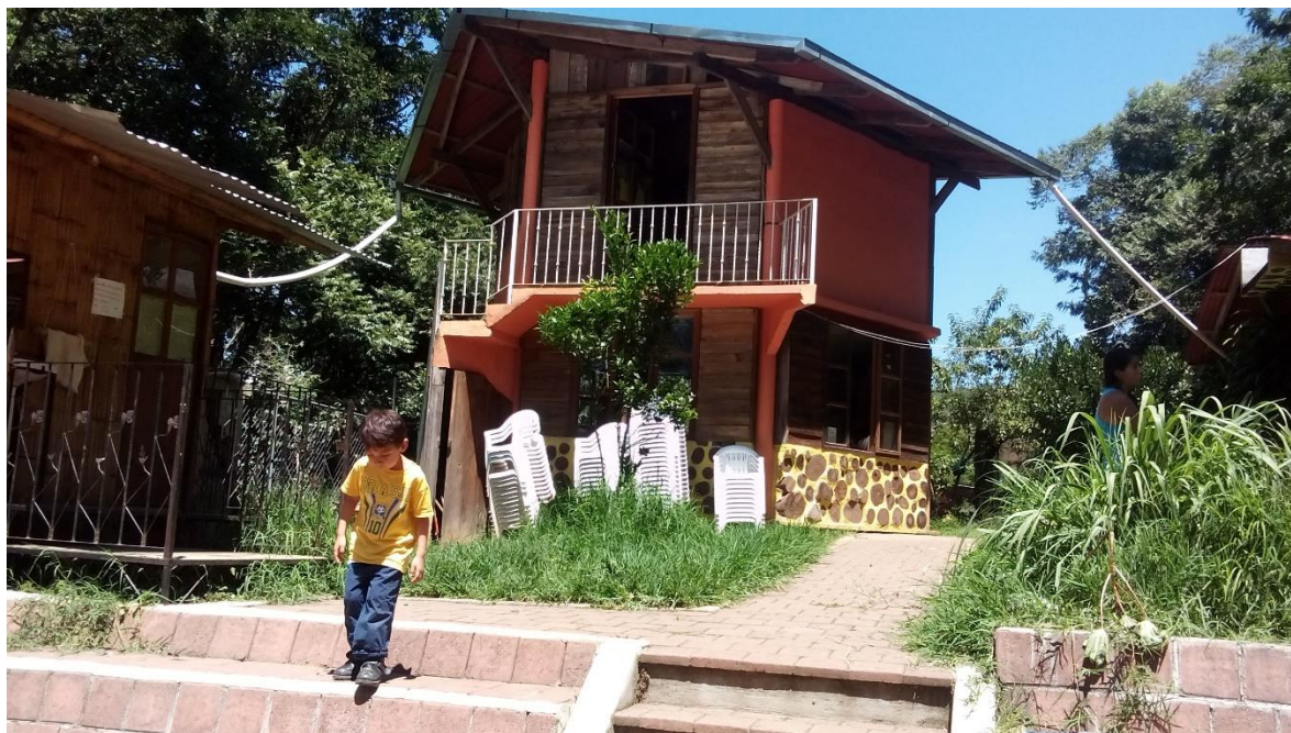
Fotografía 17. Estructura de la Escuela Ecológica
