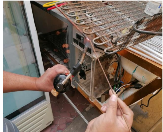
Figura 30 Soldadura de compresor y evaporador
