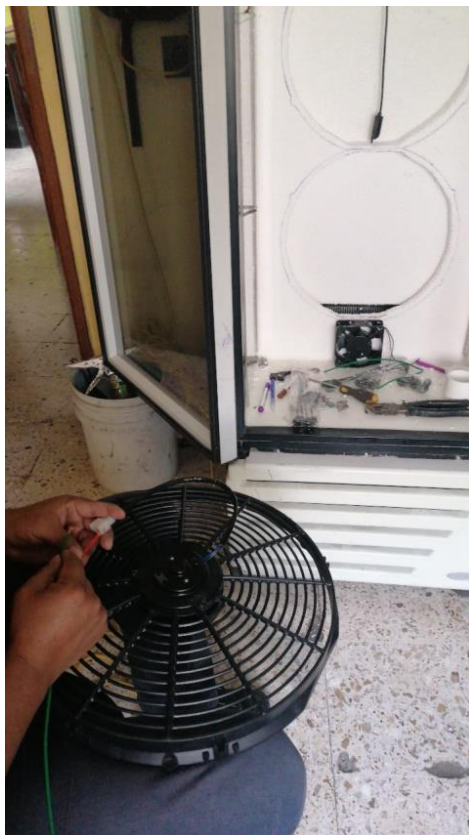
Figura 33 Cambio de ventiladores
