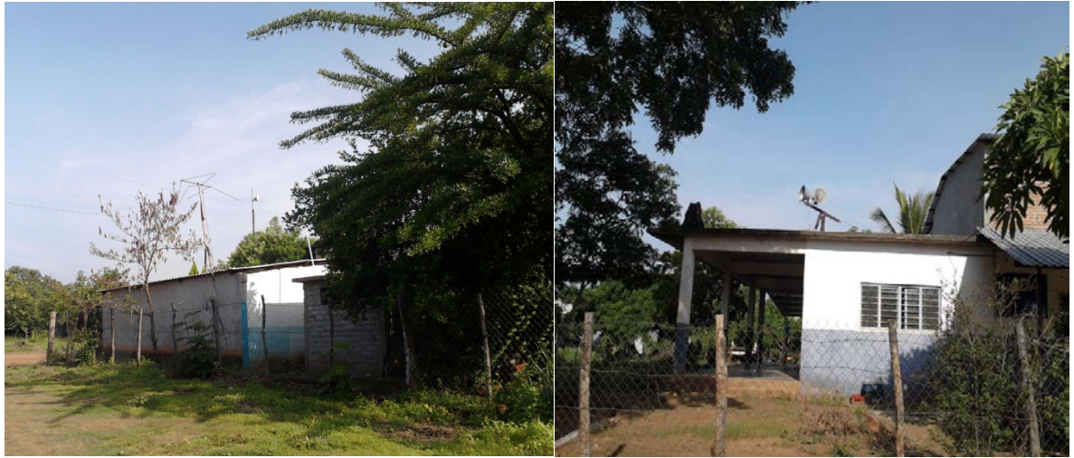
Figura 9.26 Detalle de las casetas telefónicas y medios de comunicación locales.
