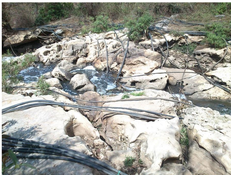
Fotografía 8. Mangueras sobre el río del túnel.
