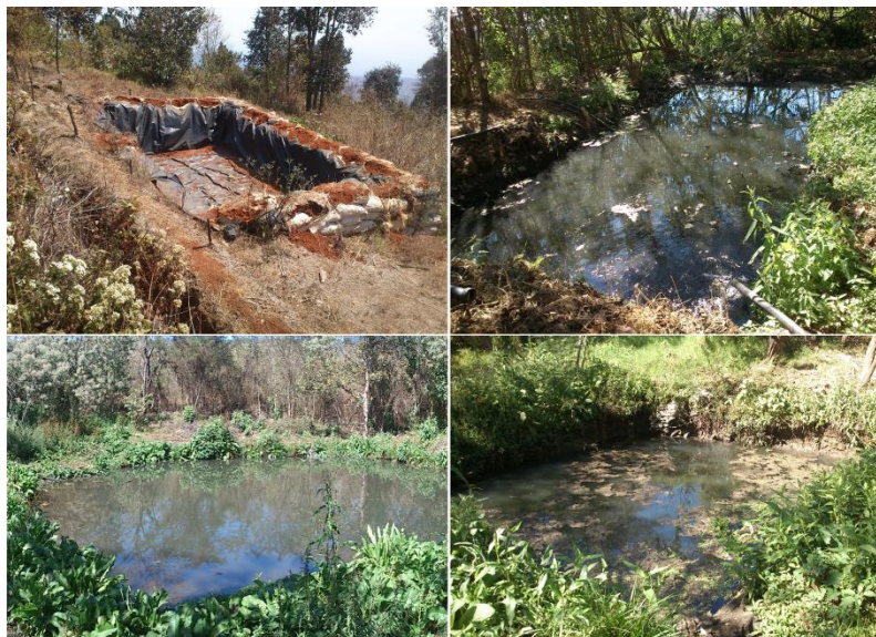
Fotografía 9. Estanques para almacenamiento y distribución del agua para riego.
