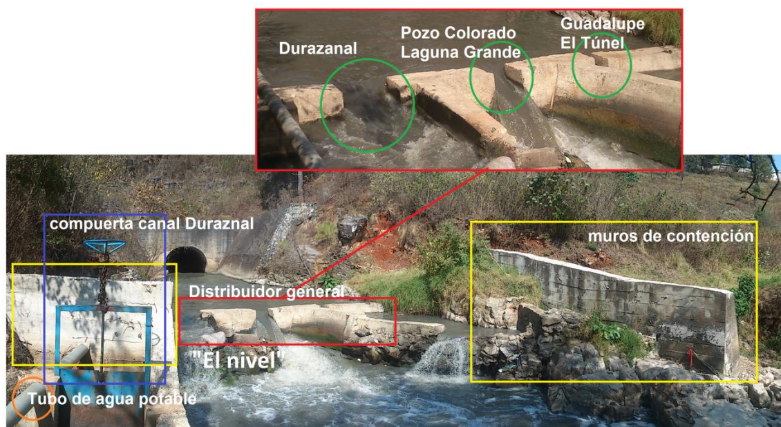
Figura 1. Infraestructura en la bocatoma del sistema de riego.
