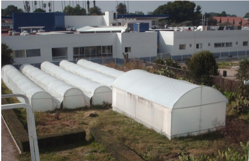
Figura 12 Vista de los microtúneles terminados.
