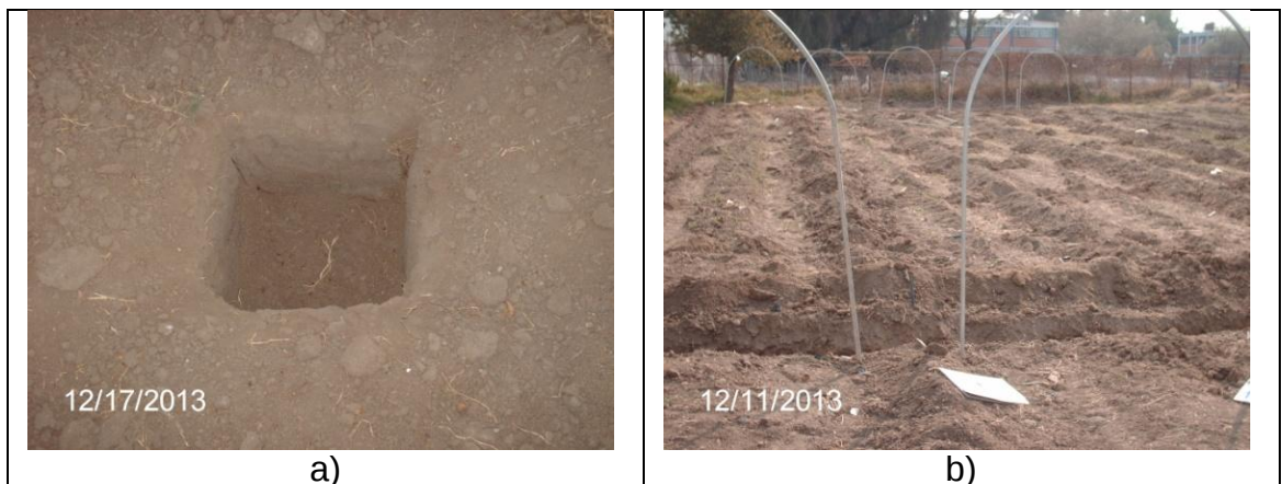
Figura 11 Trabajos necesarios para la construcción de los microtúneles a) trabajos para anclaje y b) instalación de los arcos.
