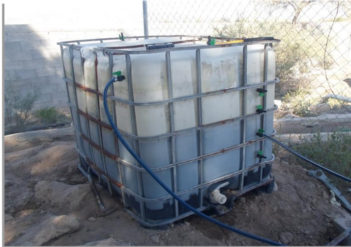
Figura 5. Montaje y operación del Reactor Anaerobio de Flujo Ascendente (RAFA).
