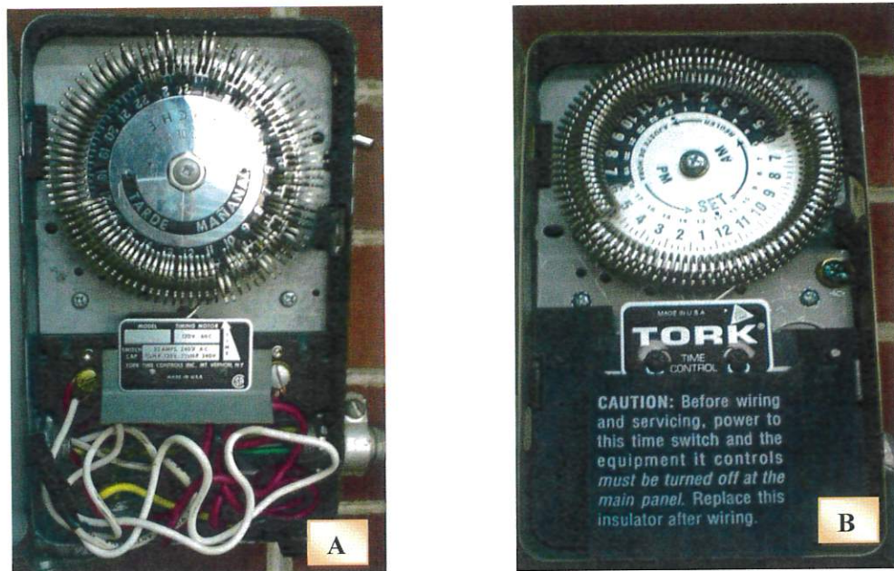
Figura 9. Controladores de los ciclos de nebulización y luz de la cámara húmeda: A) Controlador de los ciclos del nebulizador, B) Controlador de la luz.
