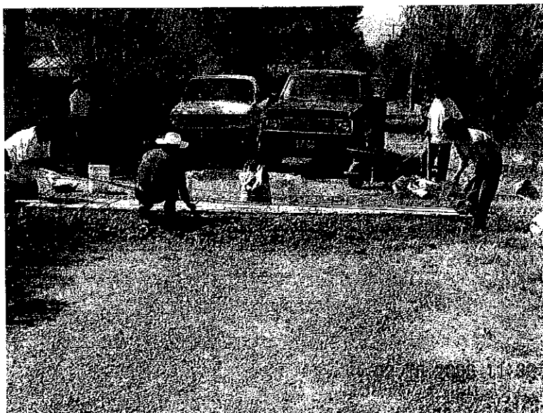
Figura No 18 Trabajando la faena para la construcción del sistema de alcantarillado
