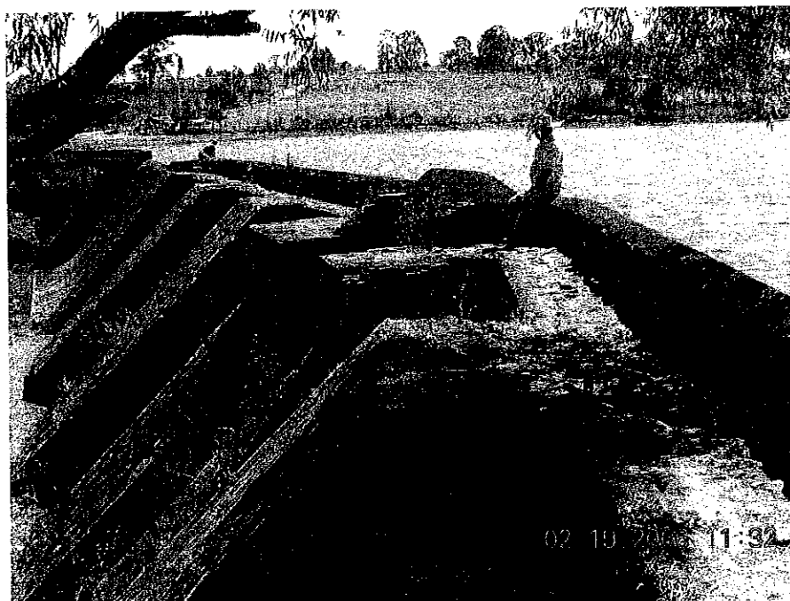
Figura No 14 Cortina de la presa de Umécuaro
