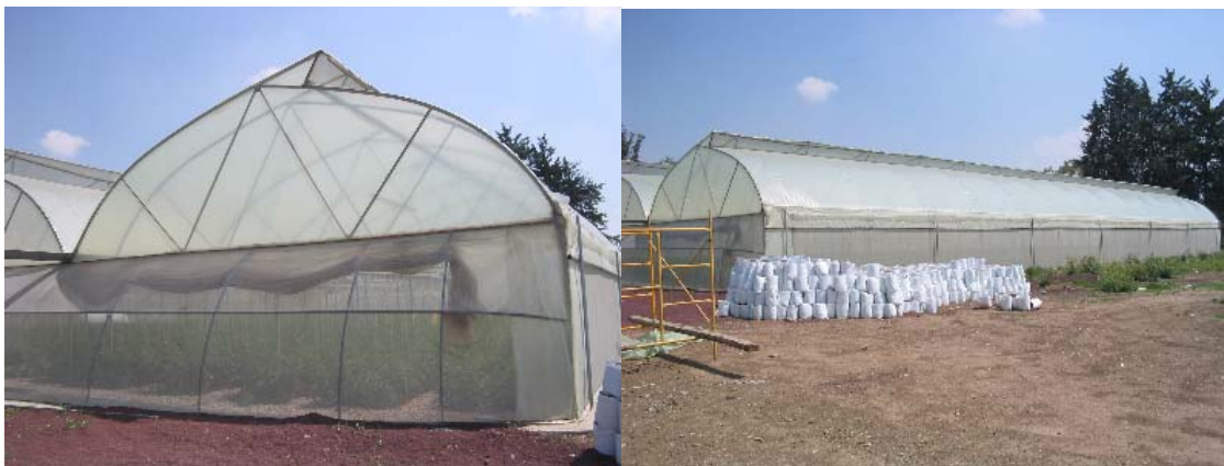
Figura 4. Invernadero del campo Tlapeaxco, Chapingo.
