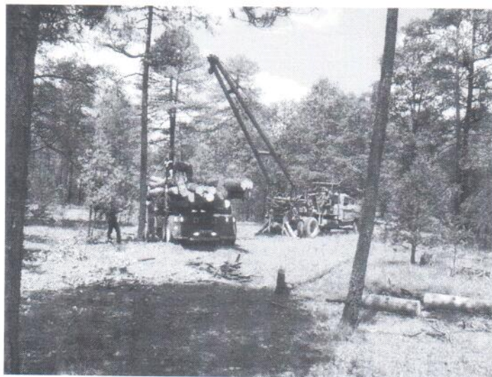
Figura. 28. Carga de camión con motogrúa (panorámica)
