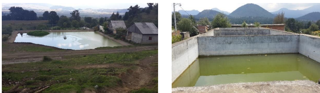
Figura 15. Obras hídricas para el almacenamiento de agua en San Miguel Pomacuarán. Fuente: Tomada por Diana Fuerte.
