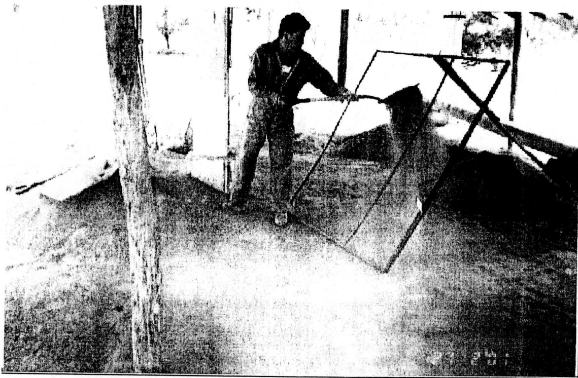
Figura 17. Proceso de tamizado del sustrato base con ayuda de una malla metálica (cedazo) de 0.5 a 1 cm de abertura, para eliminar del mismo las piedras u otro material no deseado, previo a la mezcla en la proporción requerida (Tomada por Perera, 2000).
