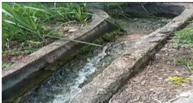
Figura 2. Canales de riego para la caña de azúcar
