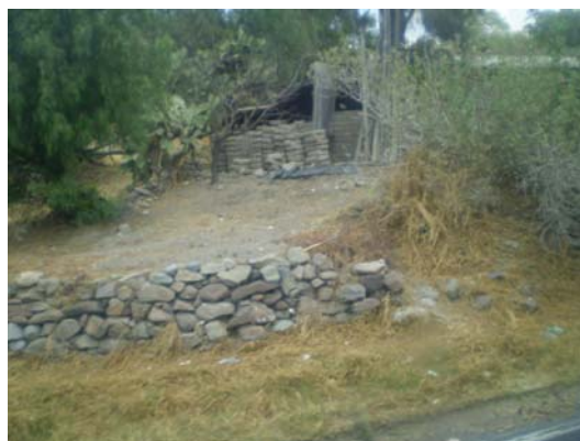
Vivienda a la orilla de la carretera
