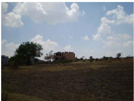
Construcción de vivienda en las parcelas
