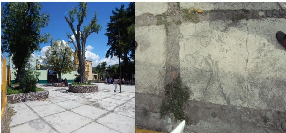
Fotografía 1. Construcción banquetas plaza cívica; iniciales y fecha de amonestados por pleitos familiares
