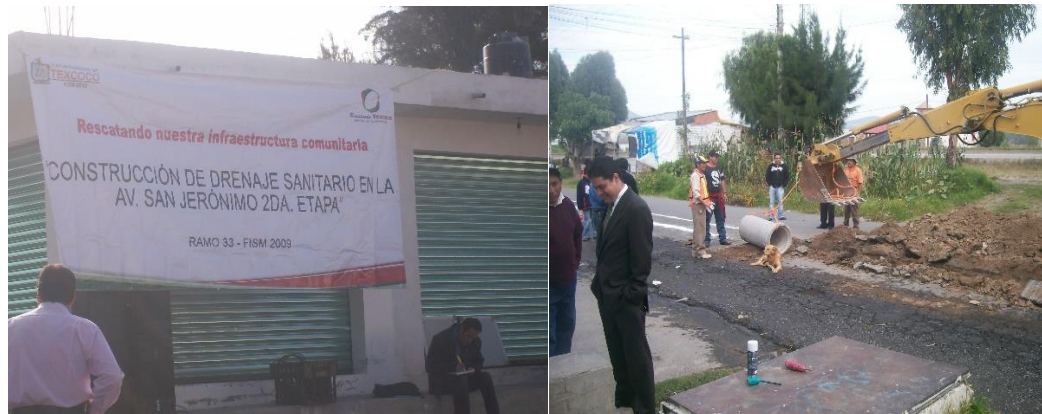
Fotografía 2. Construcción de drenaje comunitario
