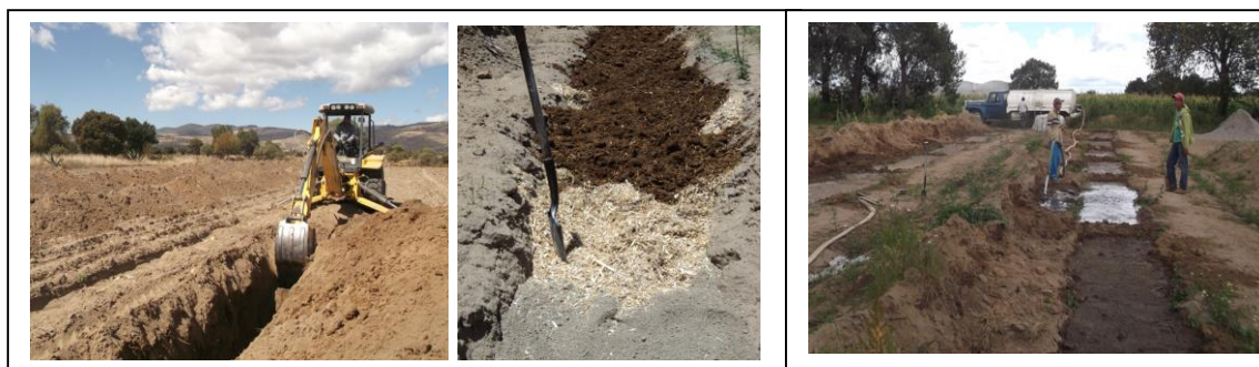
Figura 1. Excavación y llenado de cepas-zanjas.
