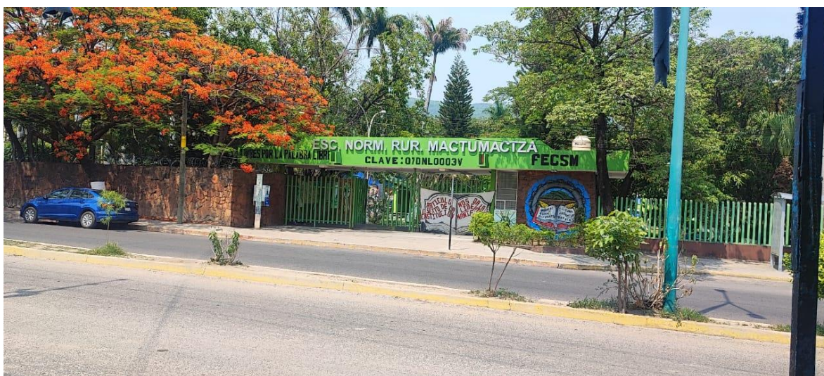
Figura 26: Entrada principal a instalaciones de la ENR “Belisario Domínguez”, Mactumactzá
