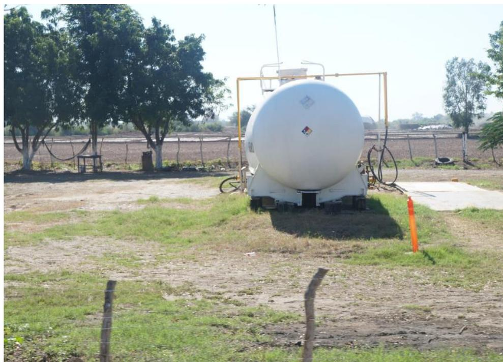
Figura 36. Tanque salchicha de agua Amoniacal ( $\text{NH}_3$ ) en la planta de venta
