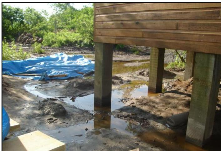
**Figura 115. Deficiente nivelación del sitio de terreno y carencia de drenes perimetrales; riesgo de proliferación de hongos en madera no preservada.**
