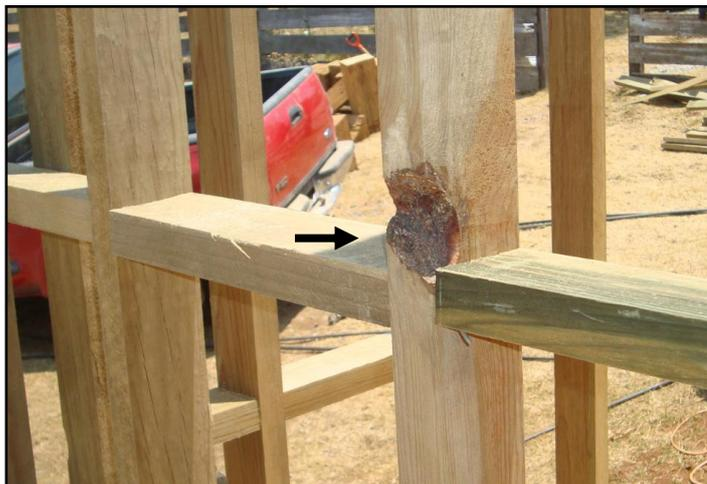
**Figura 112. Pie derecho mal clasificado, e incorrecta decisión para colocar clavo lancero; posible debilitamiento y falla por compresión.**
