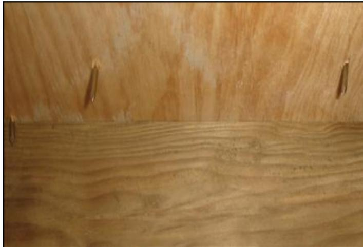
**Figura 110. Clavado incorrecto, posible levantamiento del tablero.**
