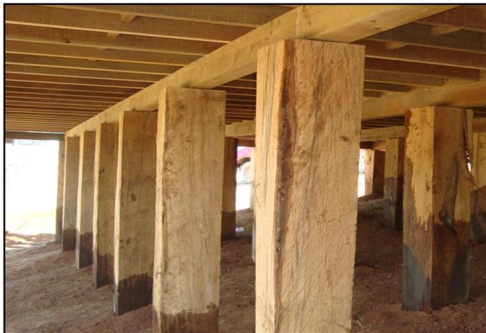
**Figura 114. Madera no preservada en contacto con el suelo; alto riesgo al ataque de termitas y posible colapso de la estructura.**
