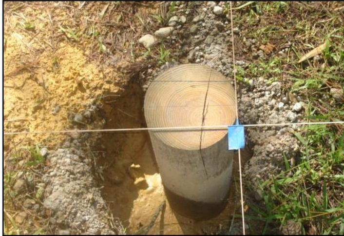
**Figura 113. Deficiente excavación para la ubicación de los postes; variación en la ortogonalidad y paralelismo de la cimentación.**
