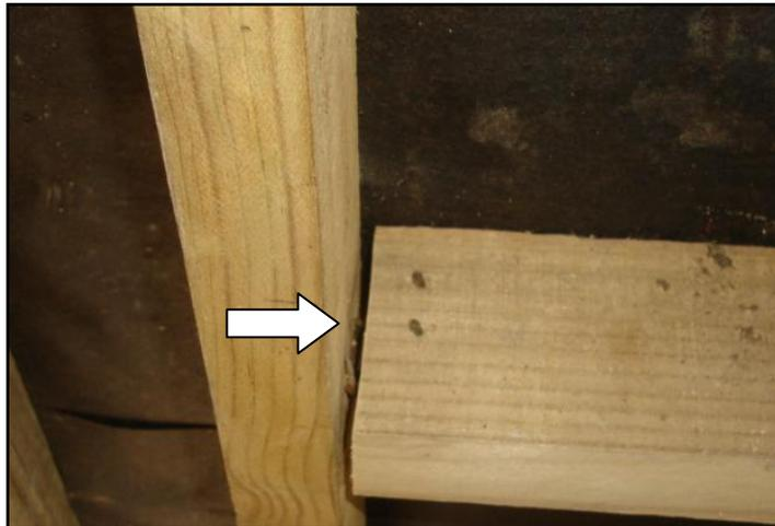
**Figura 108. Unión incorrecta entre el pie derecho y el cortafuego con clavo lancero.**
