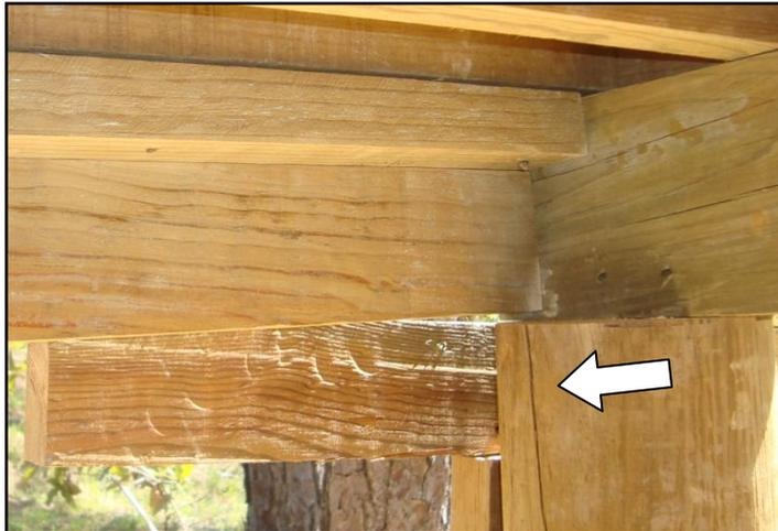
**Figura 107. Mínima área de soporte de la viga en la rajadura del poste, posible cortante y falla en la esquina.**
