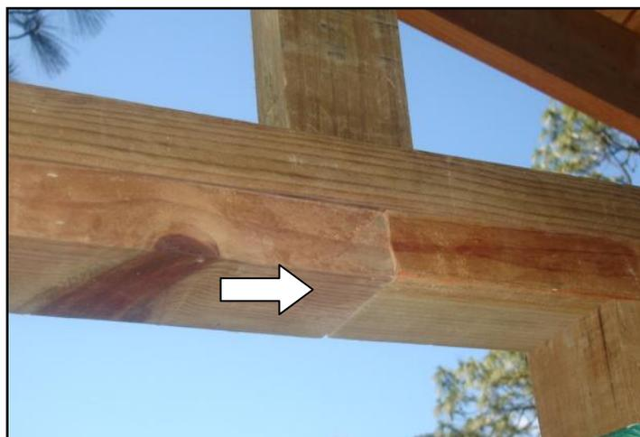
**Figura 106. Unión incorrecta entre la solera superior; deflexión y riesgo de separación de la pieza debido a la carga de compresión.**
