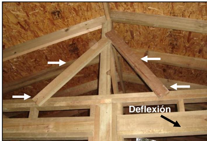
**Figura 105. Arriostramiento deficiente y presencia de deflexión.**
